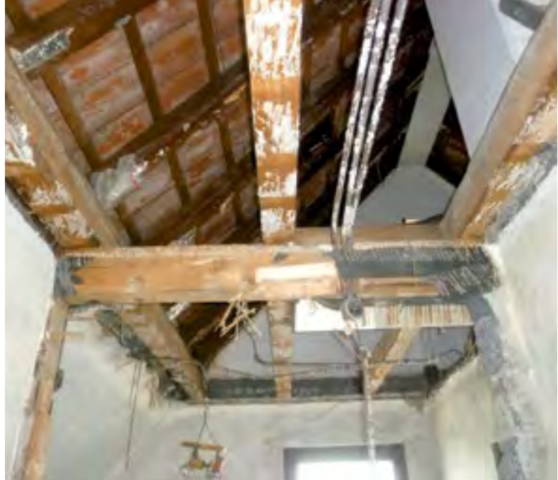
Die Dachsparren wurden von 12 auf 24 Zentimeter aufgedoppelt: Zwischen den Sparren wurde Zellulose eingeblasen, darüber liegen 3,5 Zentimeter starke Holzweichfaserplatten als Aufsparrendämmung.
