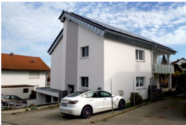
Das Wohnhaus der Familie Orzada nach der Sanierung.
