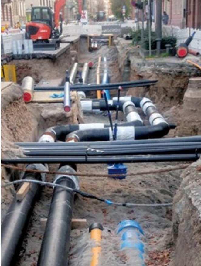
Der notwendige Ausbau der Fernwärme bedeutet viele Baumaßnahmen und somit auch Beeinträchtigungen für Anwohner und Verkehr.
