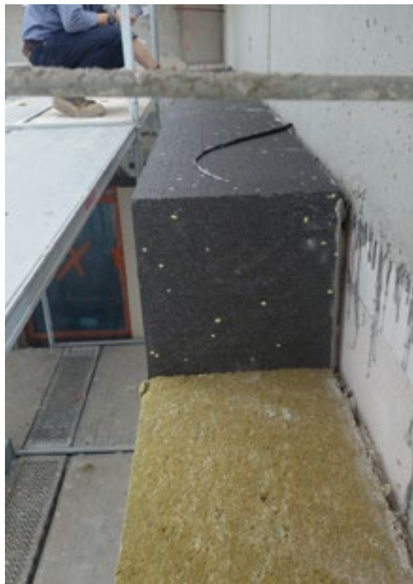
Bild rechts Bedingt durch den notwendigen Brandschutz kommen bei der Außenwanddämmung verschiedene Dämmstoffe gleichzeitig zum Einsatz – die KLiBA überprüft, ob die geplanten Dämmstoffe und Dämmstärken eingebaut werden.
