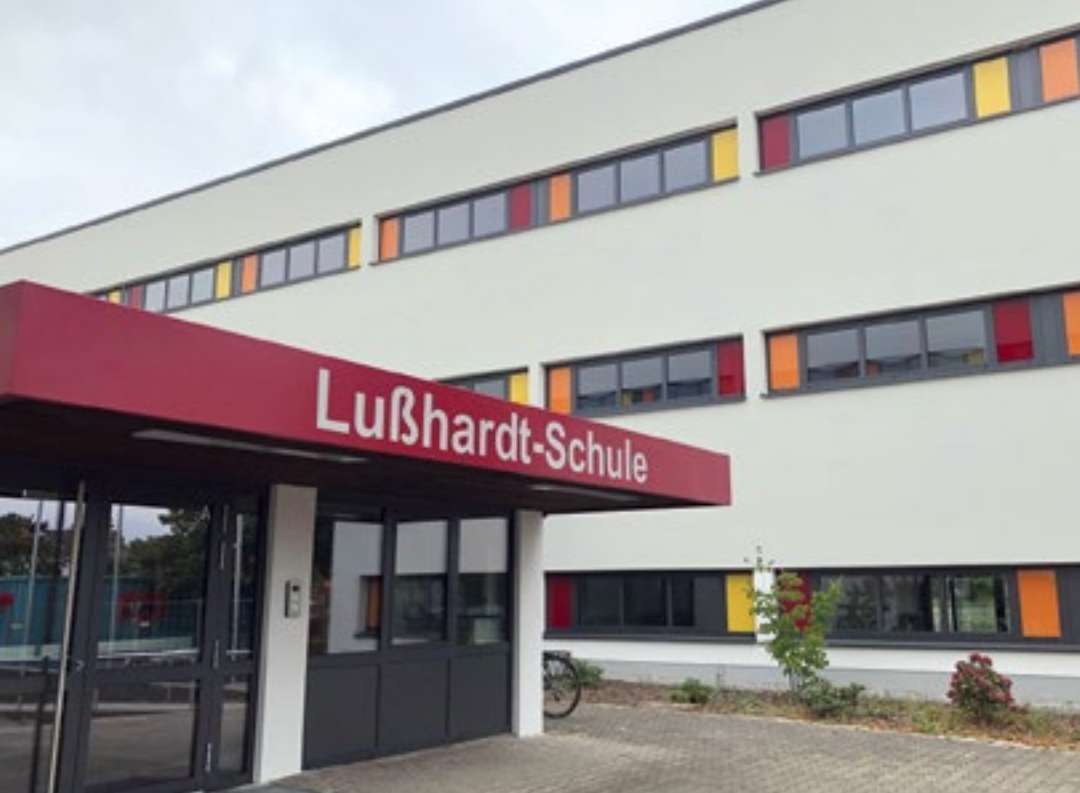
Bereits während des Beratungsprozesses wurde die Beleuchtung der Lußhardt-schule in Neulußheim auf LED umgestellt.
