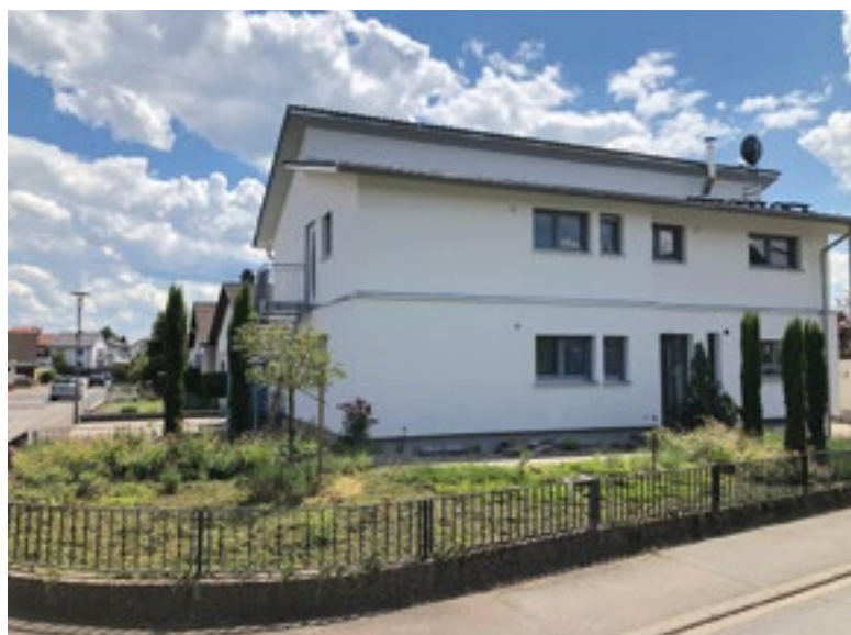
Wegen Sanierung geöffnet 2022 – ein komplett saniertes Zweifamilienhaus aus den 50er-Jahren in Sandhausen.
