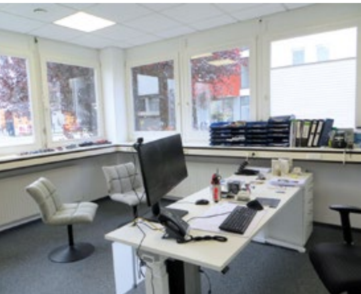
Selz & Cie GmbH Heizung – Klima – Facility Management hat bereits auf LED Beleuchtung umgestellt. Einsparpotenzial gibt es noch bei der Beleuchtungsteuerung.
