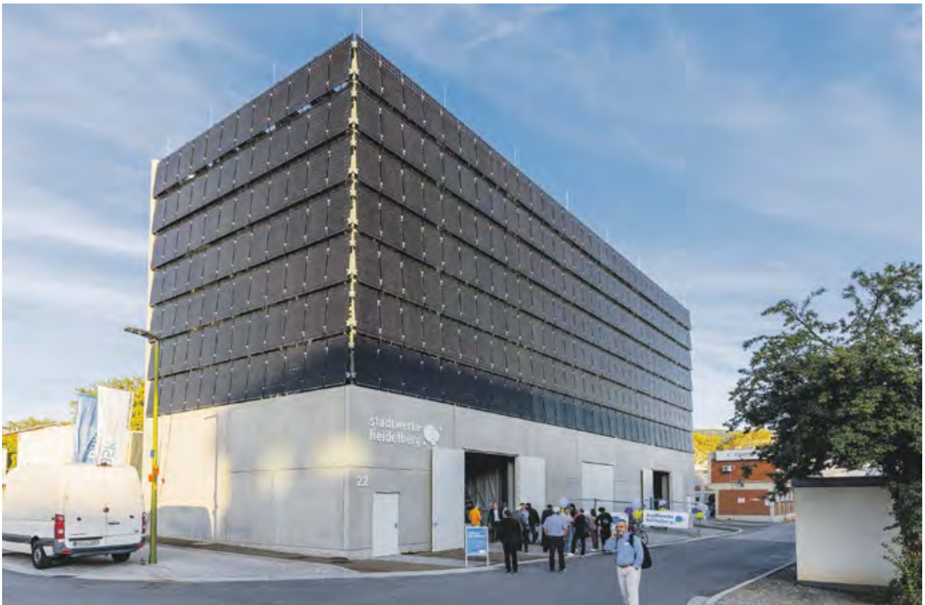
Die Kältezentrale am Europaplatz in Heidelberg-Bahnstadt mit ihrem „Solarhut“: An allen vier Seitenwänden sowie auf dem Dach sorgen Solarmodule für einen Regen- und Sichtschutz und erzeugen gleichzeitig den Strom für den Anlagenbetrieb. Foto: Dittmer Fotografie.
