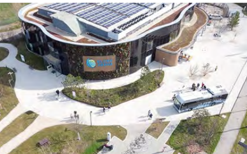
Die KLIMA ARENA Sinsheim von oben betrachtet mit großer PV-Anlage auf dem Dach. 2022 wurden ca. 320 000 kWh erzeugt.
