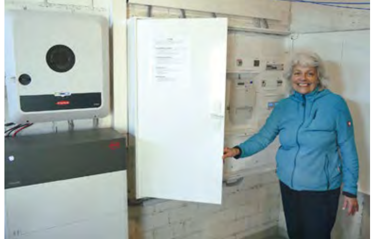
Silvia Weiß vor dem neuen Sicherungskasten und dem Stromspeicher im Keller der Mehrparteienhauses: Hier kommt die Sonnenenergie vom eigenen Dach an.
