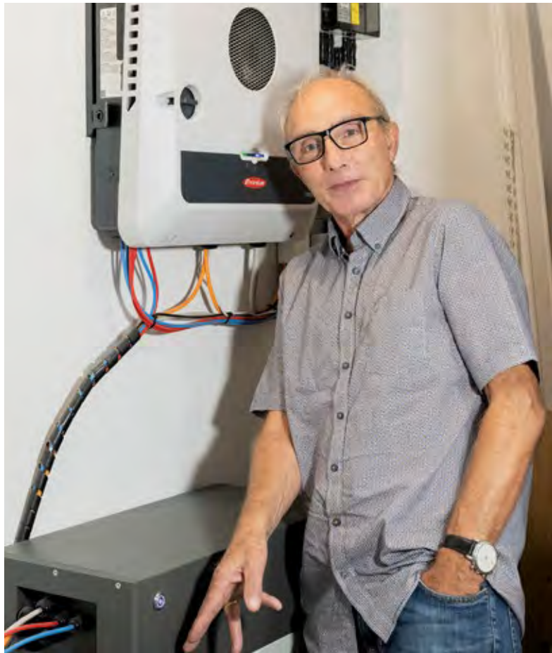
Das Herzstück jeder PV-Anlage ist ein Wechselrichter – er wandelt den in der PV-Anlage erzeugten Gleichstrom in Wechselstrom um.
