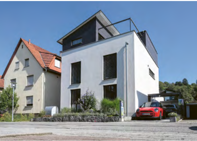
Modern und technisch – Wohnhaus und Architektur-Büro (rechts) von Veit Hunsicker in Hemsbach zeigen die Bandbreite einer energetischen Sanierung.
