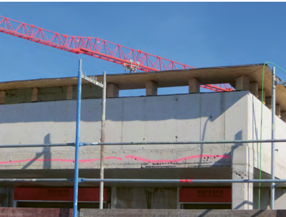
Fertigstellung der Attika im Wohngebäude schreitet voran. Zwischenräume der Holzkonstruktion werden mit Mineralfasern gedämmt.
